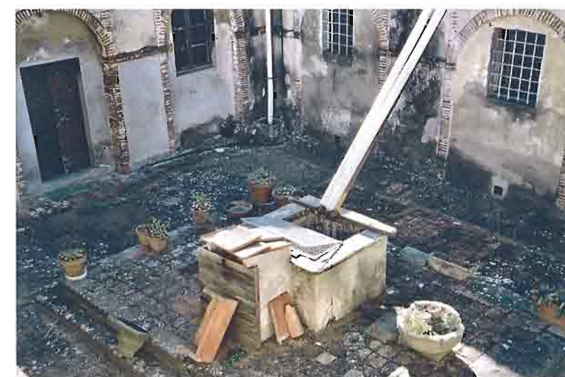
Interno del chiostro
