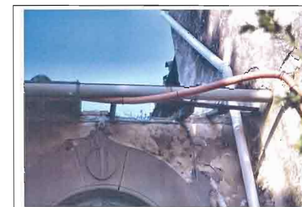
Il tetto del fabbricato d'ingresso
